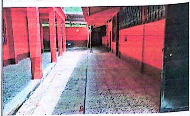
Foto 2: Finalización de piso de granito en corredores.
