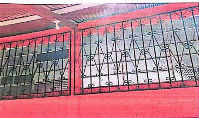
Foto 3: Finalización de ventanales
