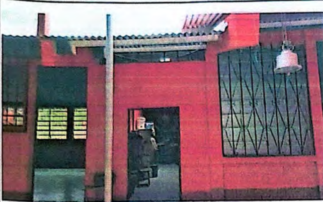
Foto 1: Remozamiento techo de bodega finalizado
